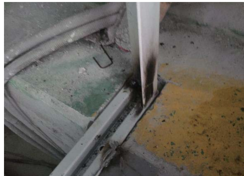
1階ゲートレール溝掘削後
