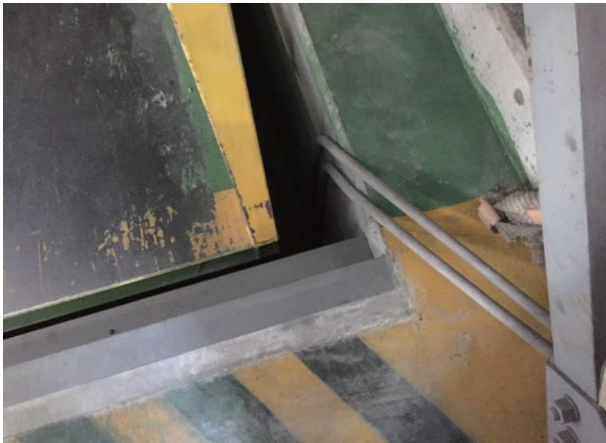
1 階ゲートレール溝掘削前
