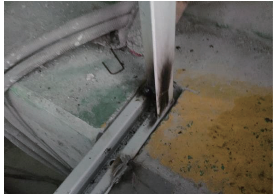
1階ゲートレール溝掘削後
